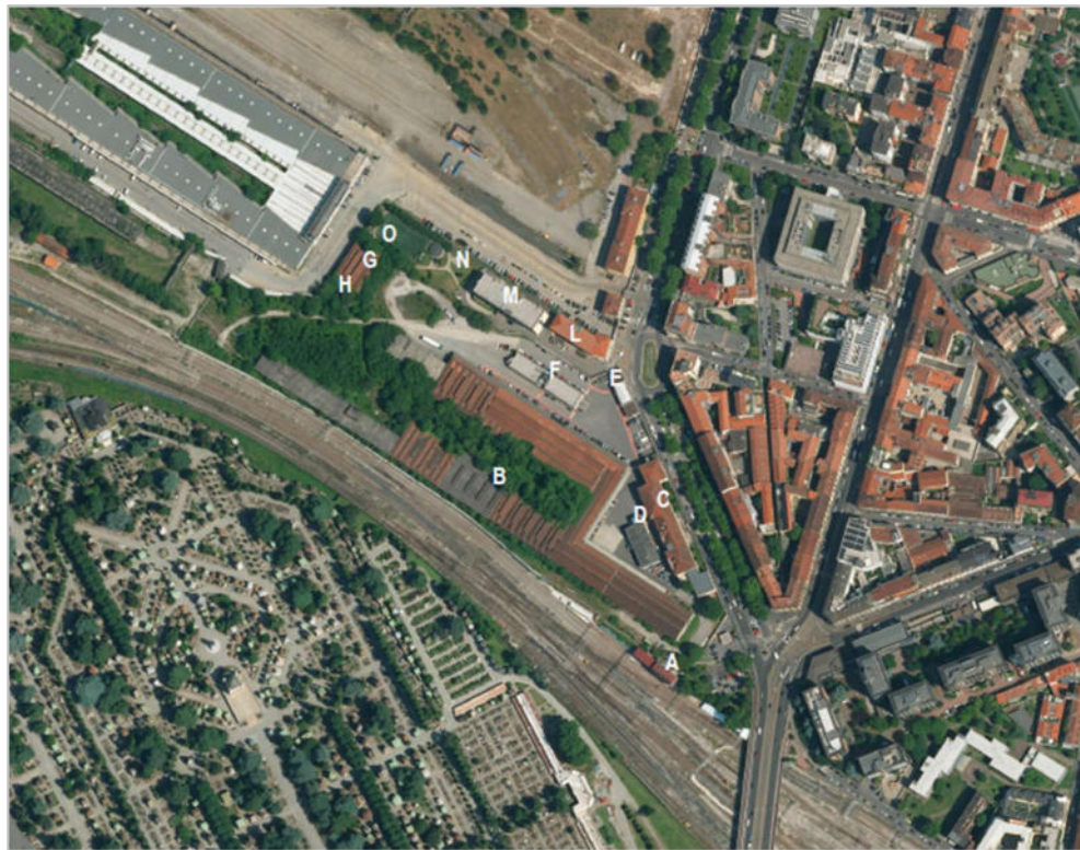
Figura 3.4: Individuazione edifici esistenti nell'area Unità Valtellina su catastale e su ortofoto (Dogana edifici A, B, C, D, E, F, G, H) Guardia di Finanza edifici L, M, N, O)
