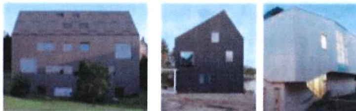
Figura 2.12 esempi di realizzazioni con finitura in pannelli di cemento
